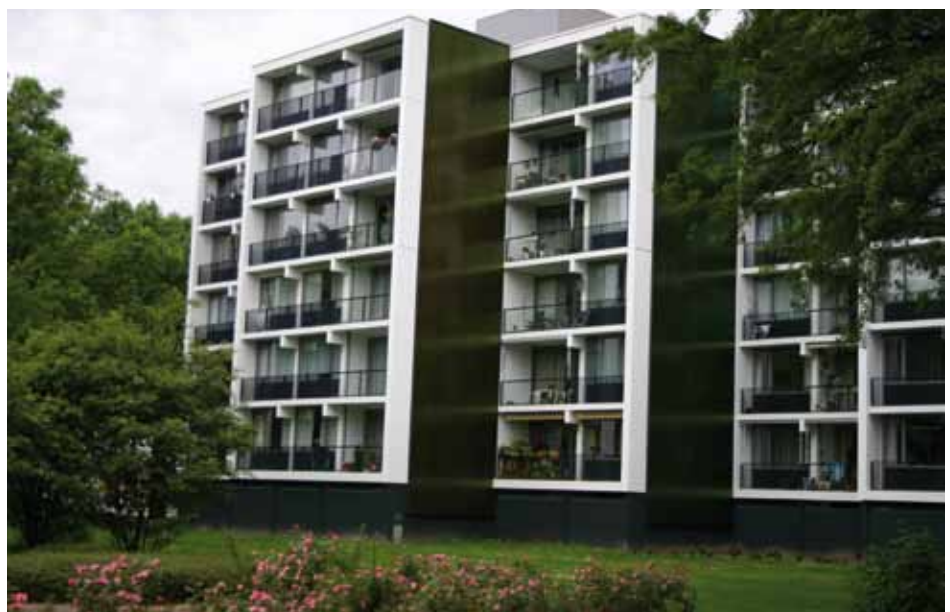
Ook de balkons werden aangepakt met nieuwe vloeren, balustraden en glaswanden.
